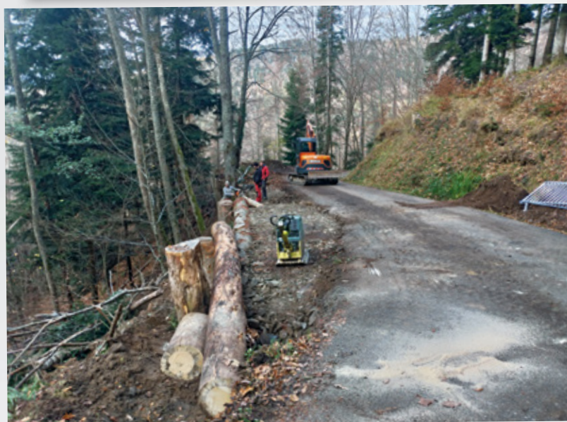
Renforcement du bas-côté de la route menant au Meerbaechel
