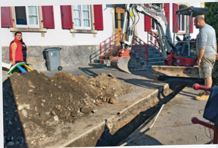
Remplacement d'une conduite d'eau potable au cercle
