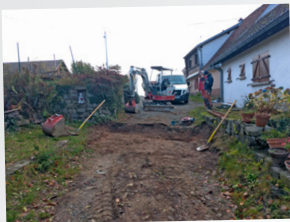
Mise en place d'un caniveau pour récupération des eaux pluviales
