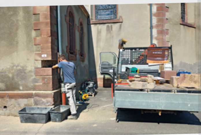
Tailleur de pierres à l'œuvre à l'église paroissiale
