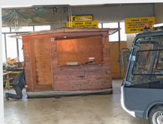
Importante remise en état de nos chalets aux ateliers municipaux
