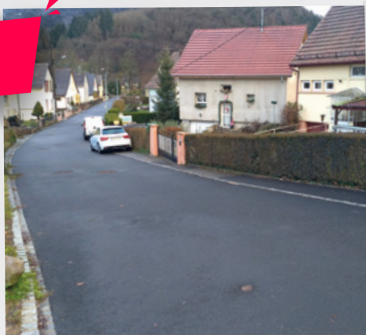
Fin des travaux de voirie rue du Puits
