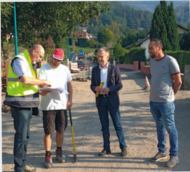
Réunion de chantier pour les travaux de voirie au Vogelbach
