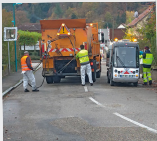
Entretien par gravillonnage de la voirie communale
